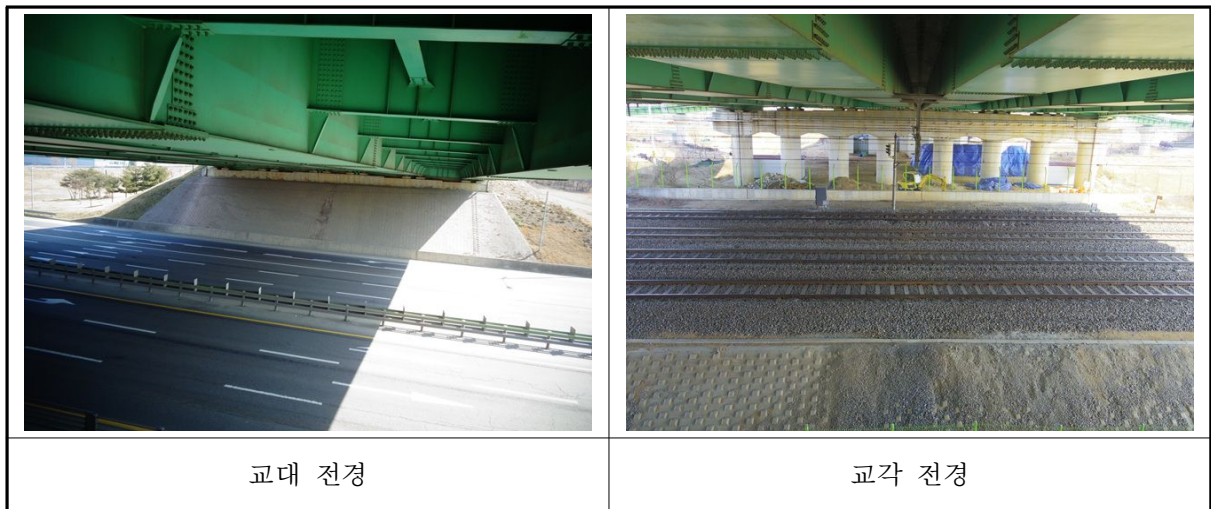
〈사진 3.17〉 교대 및 교각 전경
