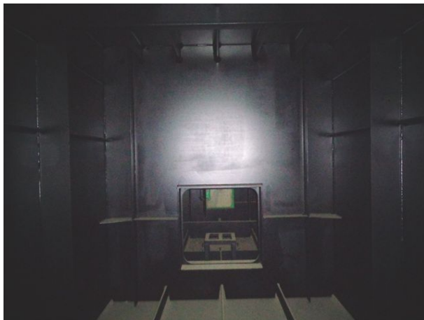
거더 내부 전경
