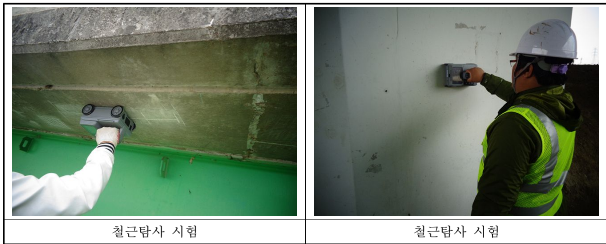
<사진 3.23> 철근탐사 현황
