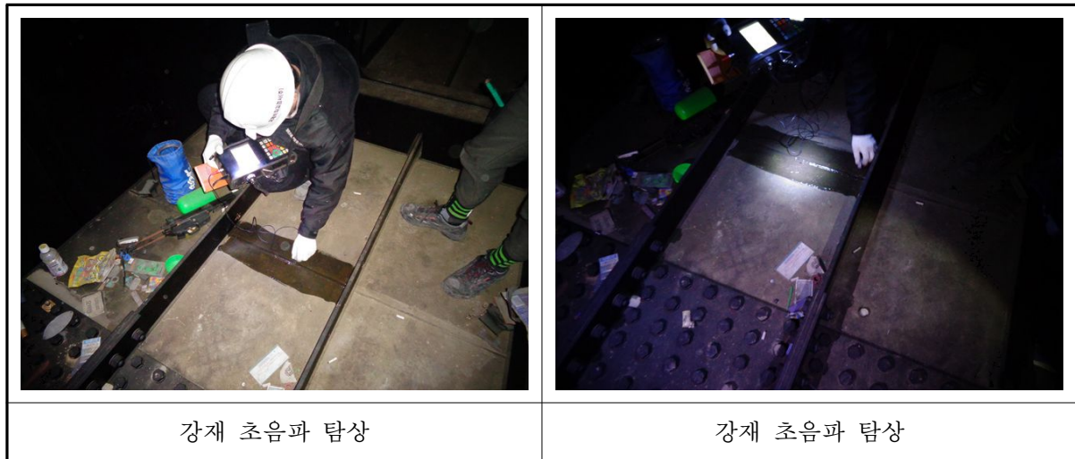
〈사진 3.27〉 강재 초음파탐상시험 현황
