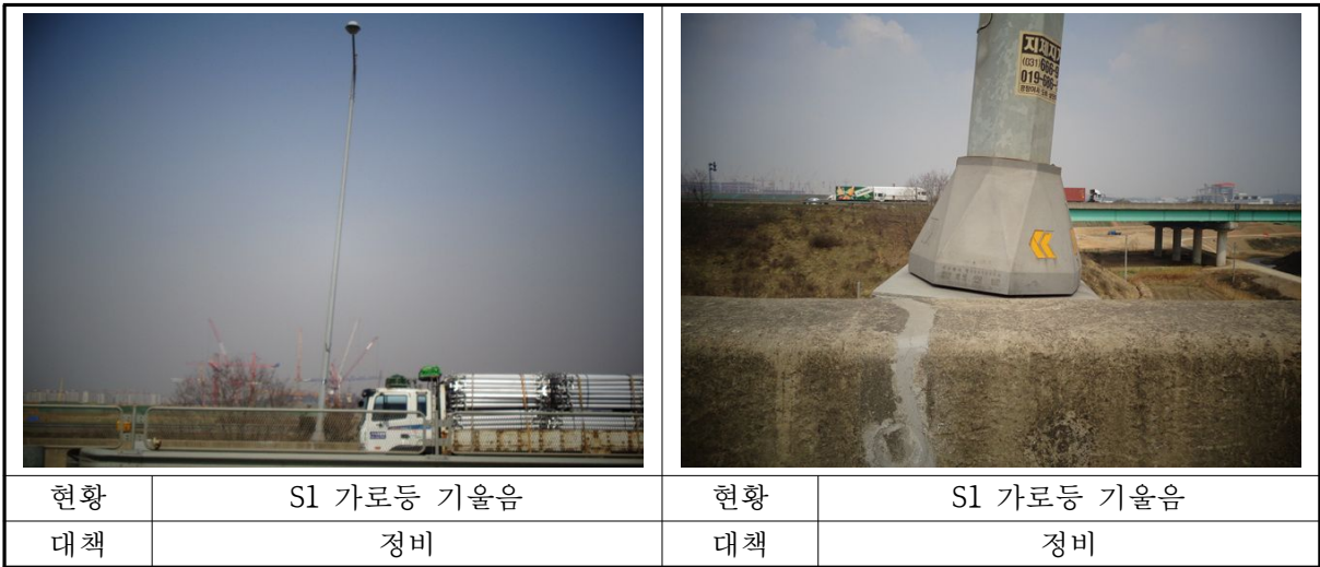
〈사진 3.20〉 부대시설 외관조사결과
