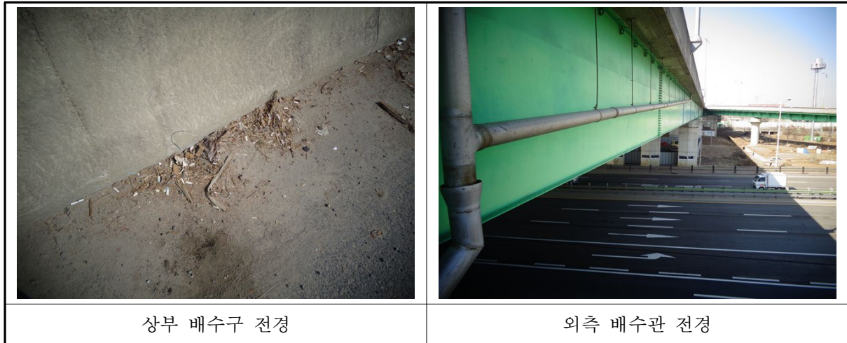
〈사진 3.6〉 배수시설 전경
