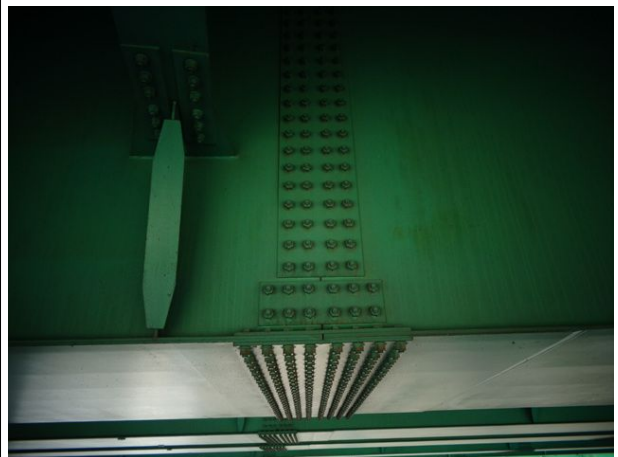
거더외부 스플라이스 전경
